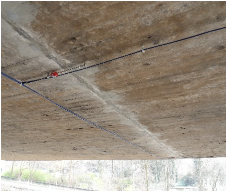
Darstellung Koppelfuge mit Wegaufnehmer
